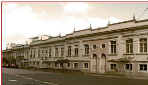
Figura 4 – Conjunto de oito sobrados da Santa Casa
