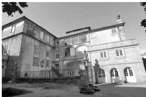
Figura 10 – Fachada tardoz do Palácio do Raio (antes da reabilitação)
