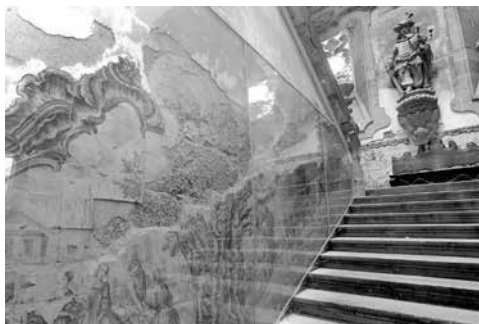
Figura 11 – Escadaria nobre do Palácio do Raio (antes da reabilitação)
